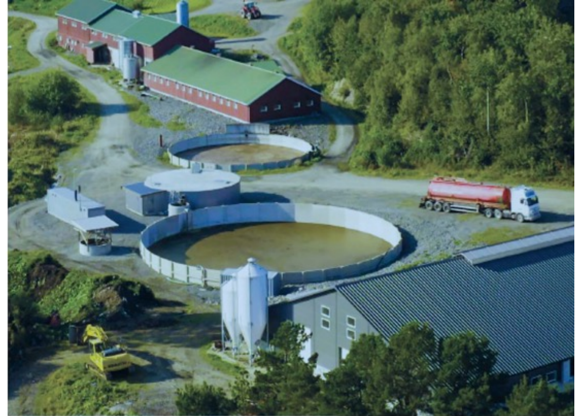
Biogassanlegg hos Inge Hoemsnes.
